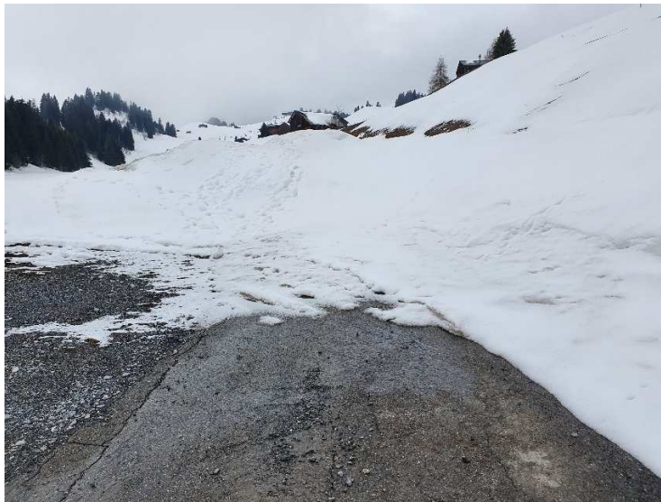
Standort Adamsgada 09.04.2019, Start Bauarbeiten 2019
