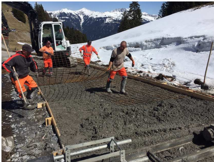
Betonieren bei Adamsgada am 01.05.2019
