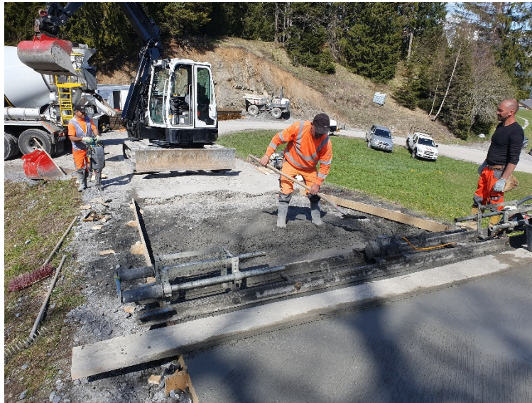
Betonieren auf Rona Bord am 23.05.2019
